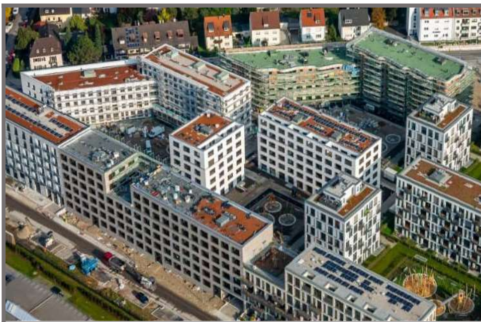
Baufelder MG03, MG02 und MG05
